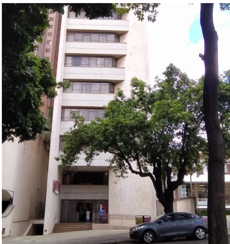
Foto 1 – Fachada do edifício
